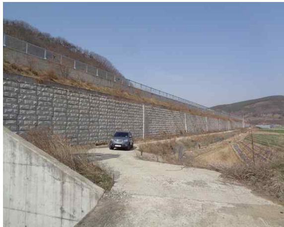
6공구 패널식 옹벽 08
