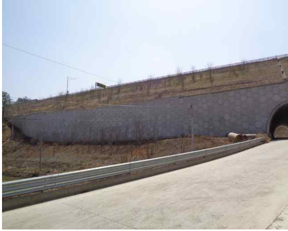
8공구 패널식 옹벽 13
