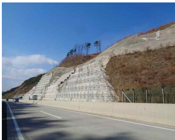
6공구 패널식 옹벽 10
