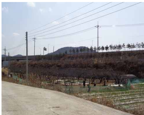
4공구 블럭식 옹벽 03
