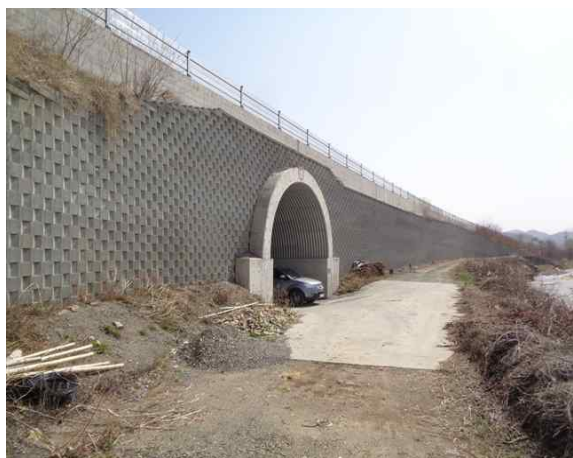
6공구 블럭식 옹벽9
