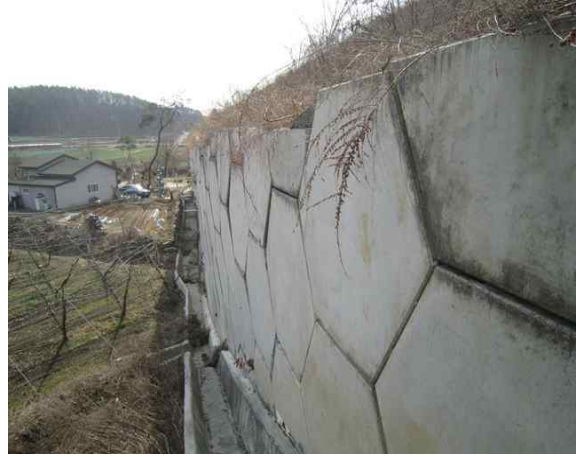
9공구 패널식 옹벽 14
