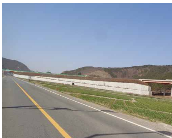
7공구 패널식 옹벽 12
