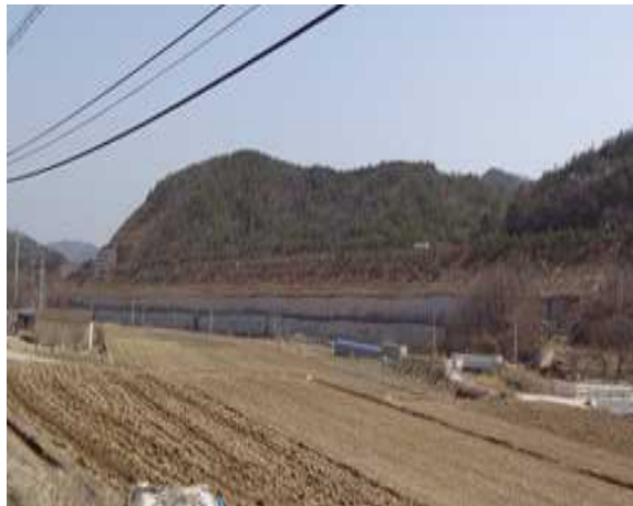
3공구 패널식 옹벽 02
