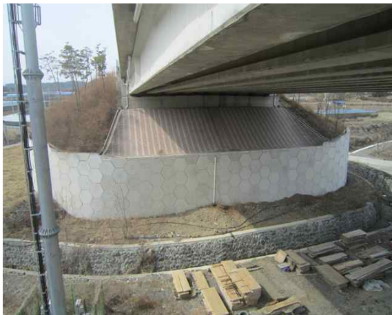
9공구 패널식 옹벽 15
