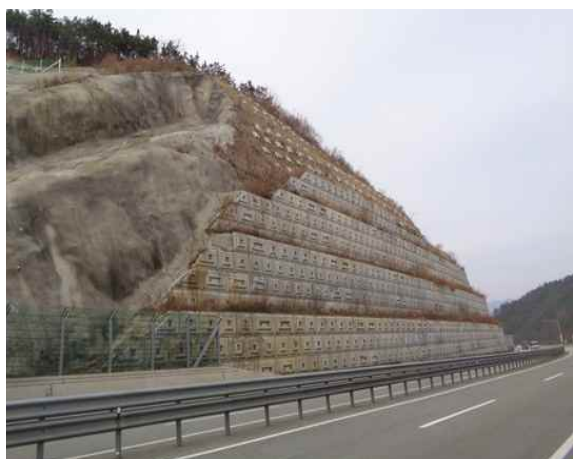
4공구 패널식 옹벽 05
