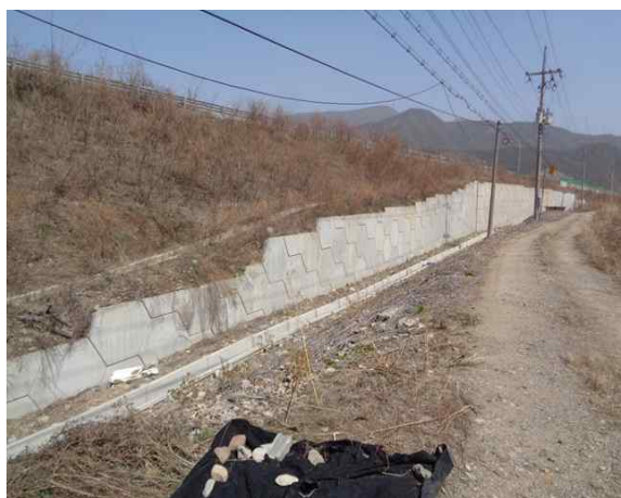
7공구 패널식 옹벽 11
