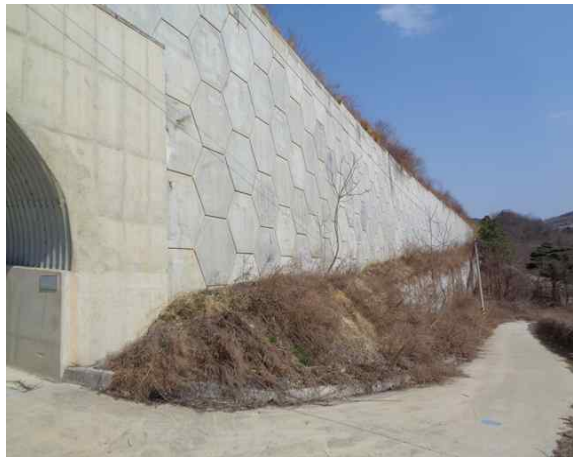
3공구 패널식 옹벽 01
