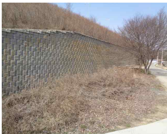
5공구 블럭식 옹벽 06
