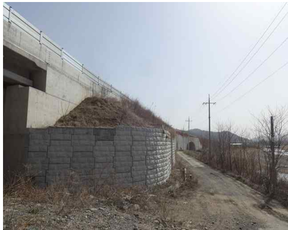
6공구 패널식 옹벽 07
