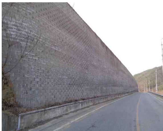
4공구 블럭식 옹벽 04
